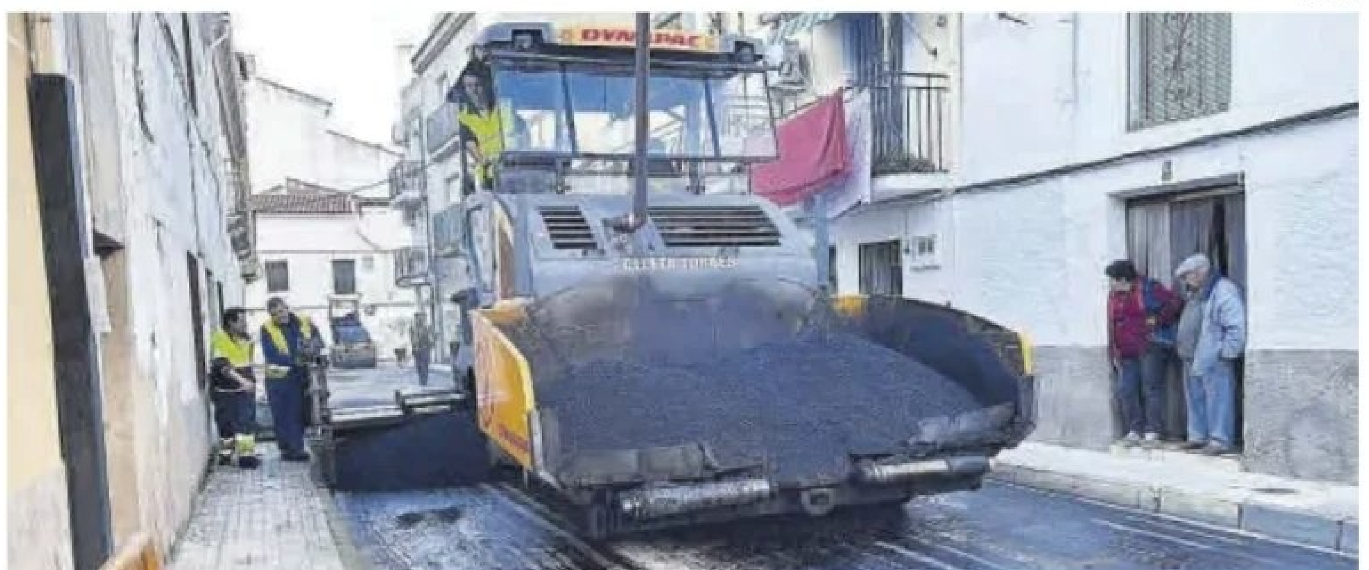
Una máquina trabaja en la renovación del pavimento de una calle en Moraleja.
