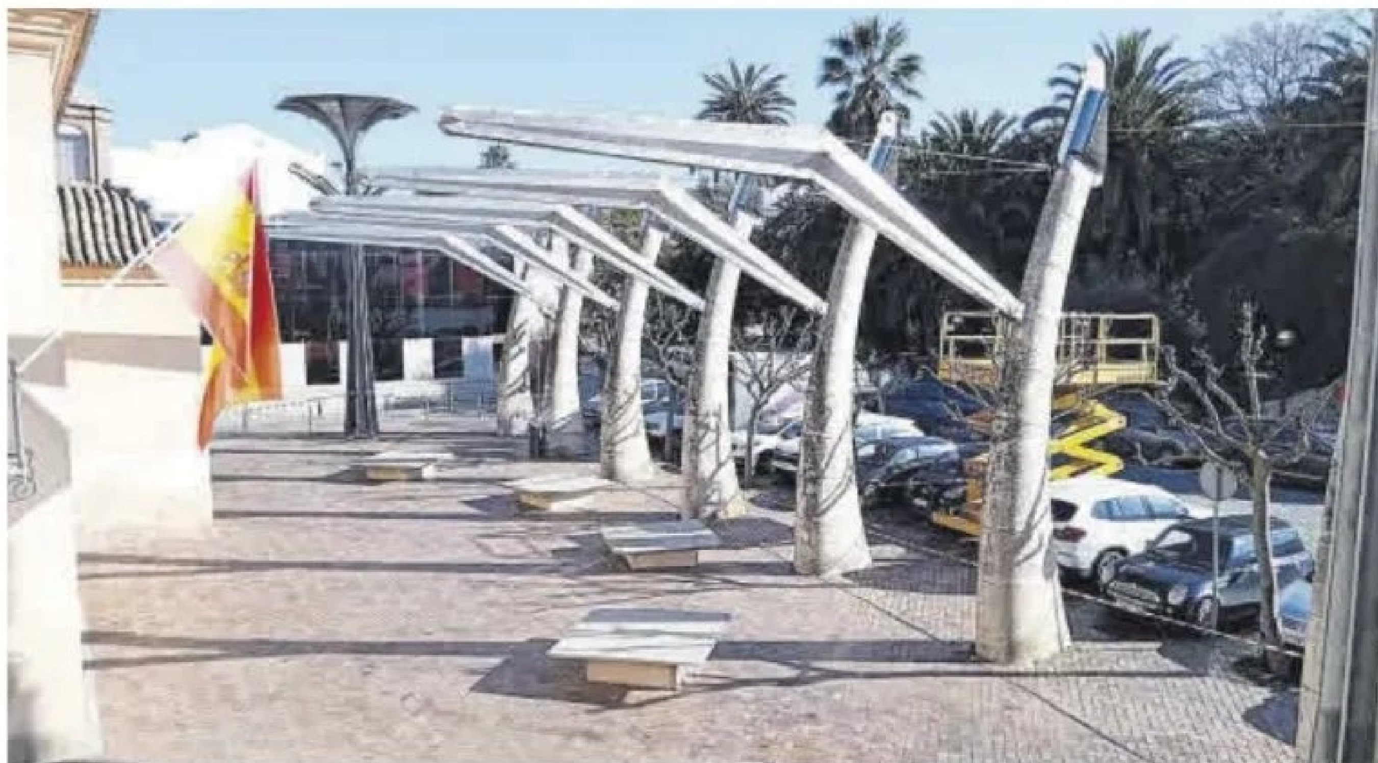
Obras de desmontaje de los telones que cuelgan de los cuernos del ayuntamiento.
